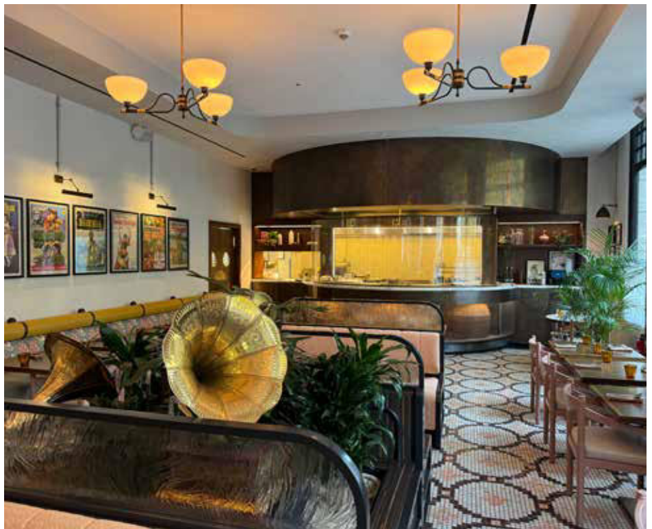
Beim Hoxton Hotel in Berlin haben die Krefelder gleich mehrere Großküchen eingerichtet, darunter eine extravagante Show-Küche mit drei indischen Tandoori-Öfen
